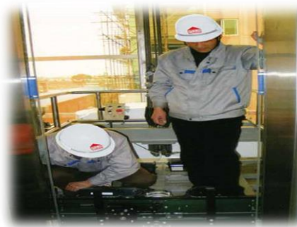
ตรวจเช็คการใช้งานของระบบลิฟท์
