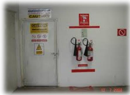
การติดตั้งอุปกรณ์ดับเพลิงภายในอาคาร
